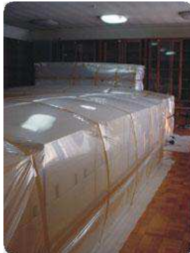
pav. Dėžės su eksponatais supakuotos į polietileninę plėvelę ir specialiu įrenginiu pakuotėje sudaroma bedegvonė aplinka.
